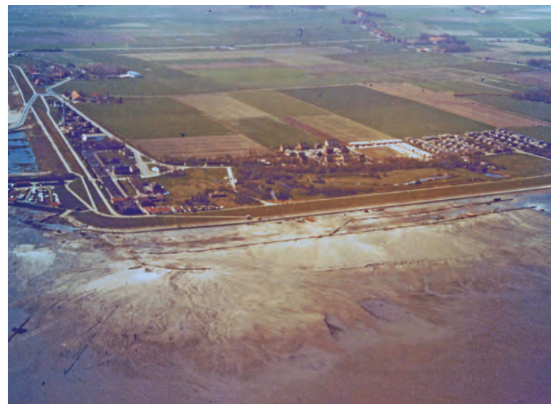
Abb. 1: Die Anfangsphase der Aufspülung. Am unteren linken Bildrand ist das Spülrohr zu sehen, durch das der Sand von der Klappstelle herangepumpt wird. Luftbild vom 20.04.1975; Quelle: Archiv WSA WHV.
