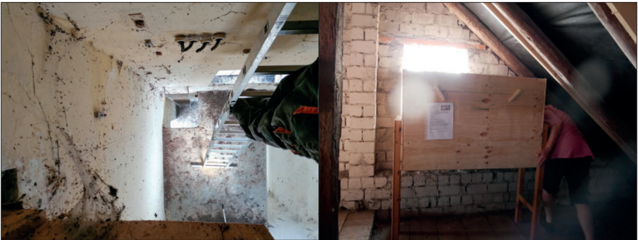
Abbildung 4: Kastenreinigung in 7 m Höhe auf einer Leiter stehend vs festem Boden unter den Füßen (Fotos: Autoren)
